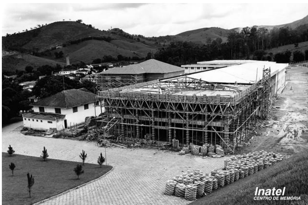
Figura 2 – Fotografia de construção do prédio 1 do INATEL na década de 1970
