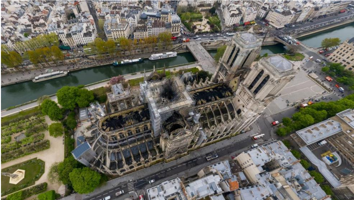
Figura 7 – Notre-Dame de Paris depois do grande incêndio de 2019.
